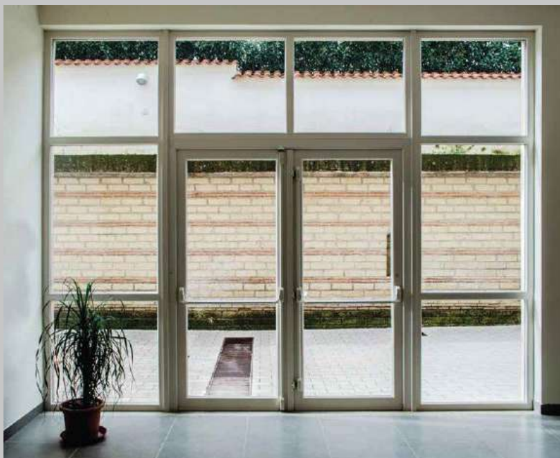
Porte apertura esterna con maniglione antipanico
